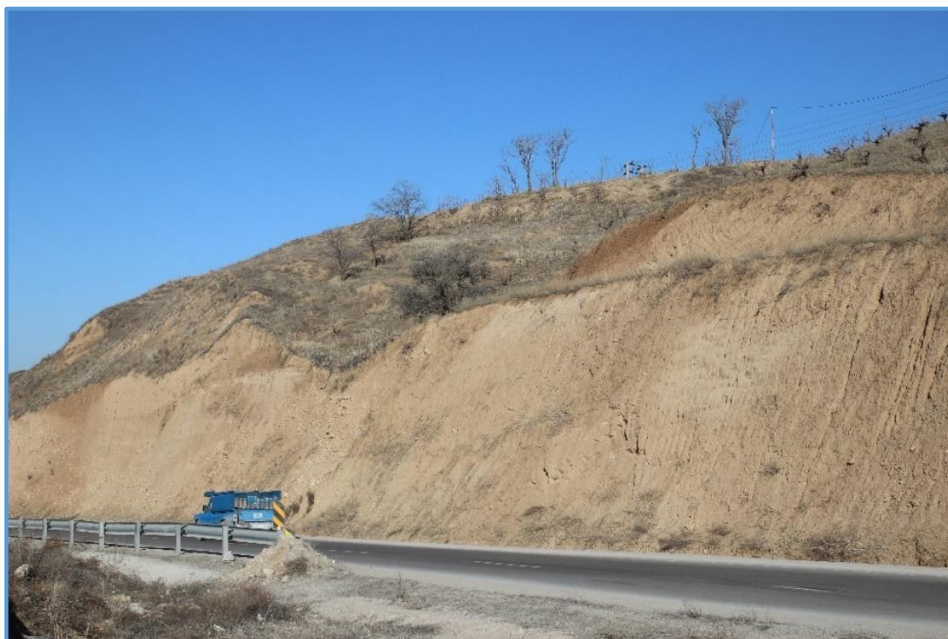
شکل ۱۵- خطر رانش و لغزش در اثر عدم اجرای استاندارد تراس های پلکانی و رعایت تناسب ارتفاع به پاشنه در کاهش شیب دامنه و ناپایدارسازی بیشتر دامنه - کیلومتر ۱۷ محور بجنورد- آشخانه ( دید به شمال باختر)- (37°30'55.88"N-57° 9'34.37"E)
