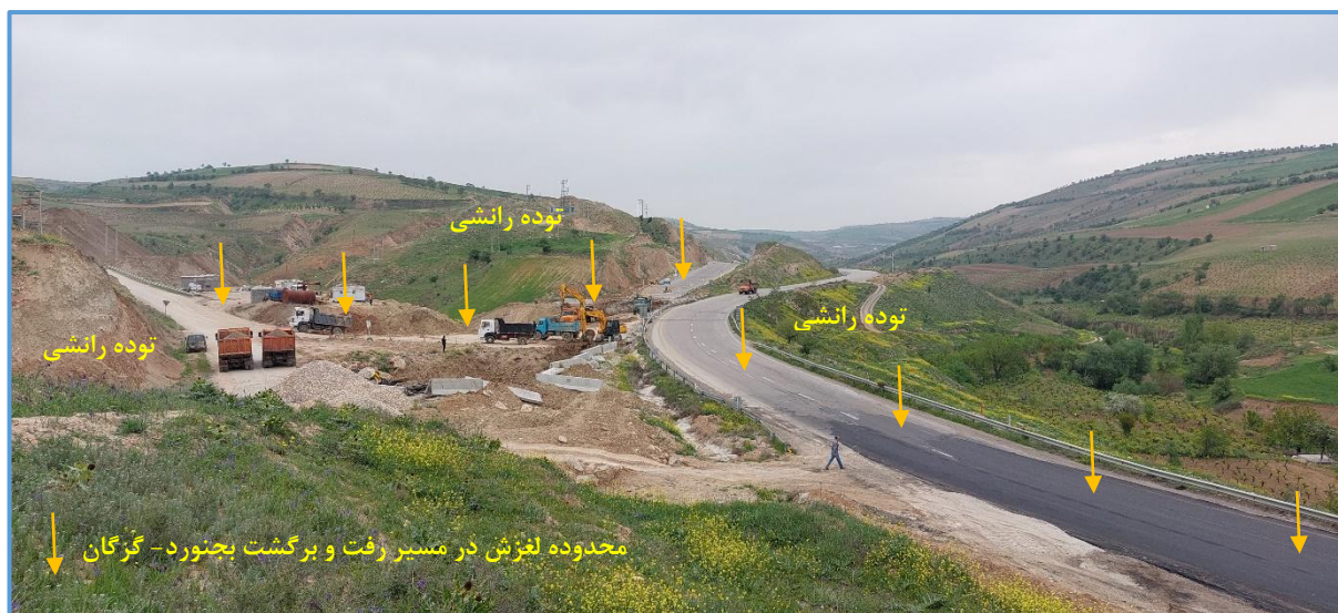
شکل ۵- نمای کلی از محل رانش جاده در دو مسیر رفت و برگشت بجنورد - گرگان در محدوده خندقلو (دید به جنوب خاور)
