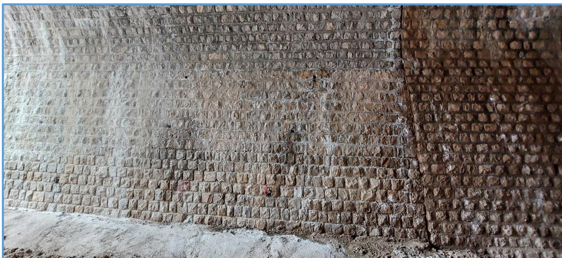
شکل ۱۲- نمایی از دیواره جنوبی پل قوسی در محل محور ناوشکل جاده، بدون تعبیه زهکش مناسب در دیواره
