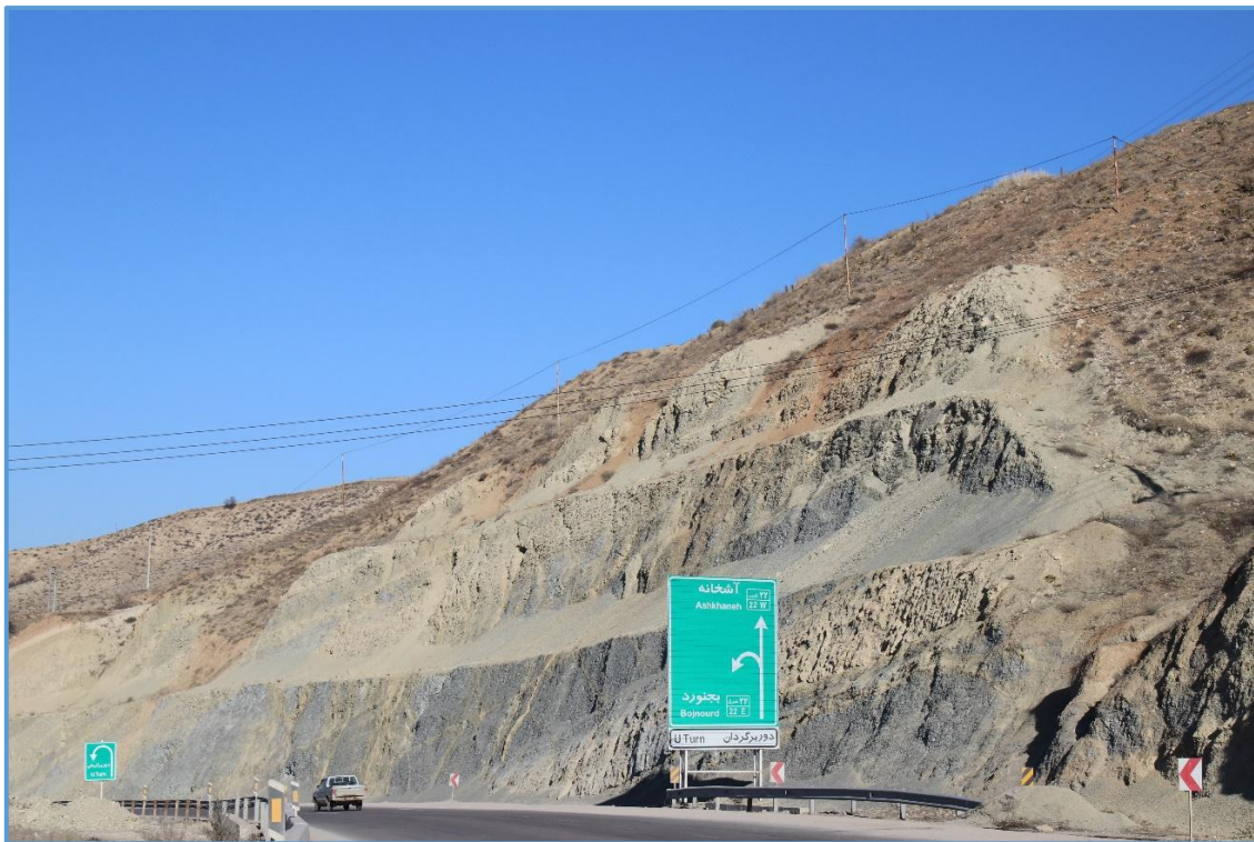
شکل ۱۴- خطر رانش و لغزش در اثر عدم اجرای استاندارد تراس های پلکانی با هدف کاهش شیب دامنه و ناپایدارسازی بیشتر دامنه - کیلومتر ۱۶ محور بجنورد- آشخانه (دید به شمال باختر) - (E 9'44.94" 57° - (N 30'50.08" 37°)
