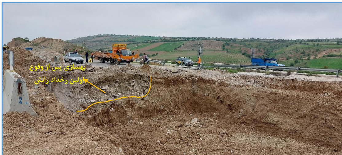
شکل ۶- نمایی از محل بهسازی مسیر رفت در اولین رخداده رانش در فروردین ماه سال ۱۳۹۹ (دید به جنوب خاور)
