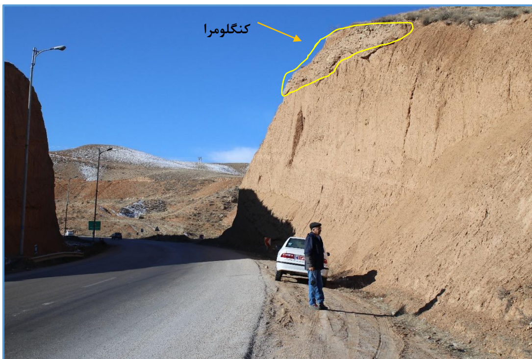
شکل ۱۹- خطر سقوط و پرتاب سنگ در اثر عدم پیش بینی حاشیه ایمن جهت مهار سقوط قلوه سنگ - کیلومتر ۵۰ محور شیروان به بجنورد - روبروی پارک بابا امان (دید به باختر) (37°30'7.27"N-57° 26'45.73"E)
