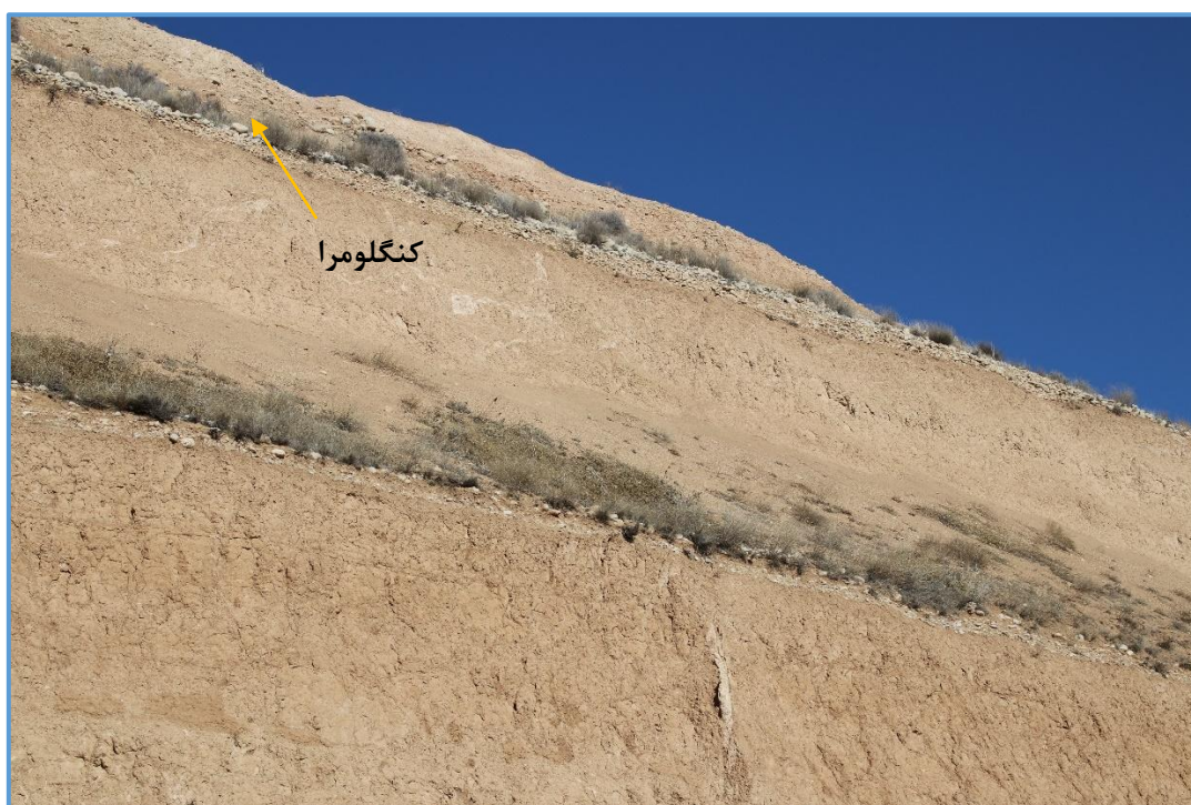
شکل ۱۷- خطر رانش و پرتاب سنگ در اثر عدم اجرای استاندارد تراس های پلکانی و رعایت تناسب ارتفاع به پاشنه جهت کاهش شیب دامنه و ناپایداری سازی بیشتر دامنه ، عدم محاسبه، پیش بینی و اجرای سکوی مهار قلوه سنگ های رها شده-۲۶ کیلومتر محور بجنورد- آشخانه ( دید به شمال)- (37°32'27.02"N-57° 4'20.13"E)
