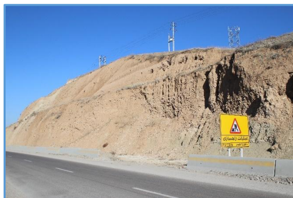
شکل ۱۵- خطر رانش و لغزش در اثر عدم اجرای استاندارد تراس های پلکانی و رعایت تناسب ارتفاع به پاشنه در کاهش شیب دامنه و ناپایدارسازی بیشتر دامنه - کیلومتر ۱۷ محور بجنورد- آشخانه ( دید به شمال باختر)- (37°30'55.88"N-57° 9'34.37"E)
