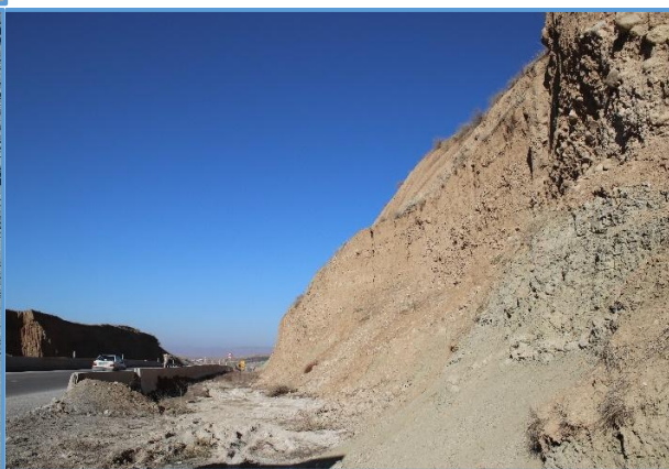
شکل ۱۶- خطر رانش در اثر عدم اجرای استاندارد تراس های پلکانی و عدم رعایت تناسب ارتفاع به پاشنه در کاهش شیب دامنه و ناپایدارسازی بیشتر دامنه - کیلومتر ۱۸ محور بجنورد- آشخانه ( دید به باختر)- (37°31'10.48"N-57° 8'57.32"E)
