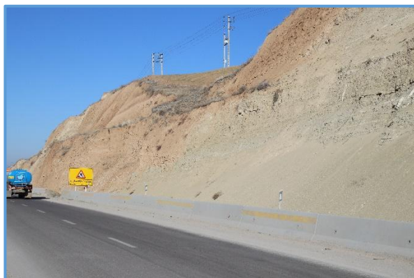
شکل ۱۵- خطر رانش و لغزش در اثر عدم اجرای استاندارد تراس های پلکانی و رعایت تناسب ارتفاع به پاشنه در کاهش شیب دامنه و ناپایدارسازی بیشتر دامنه - کیلومتر ۱۷ محور بجنورد- آشخانه ( دید به شمال باختر)- (37°30'55.88"N-57° 9'34.37"E)
