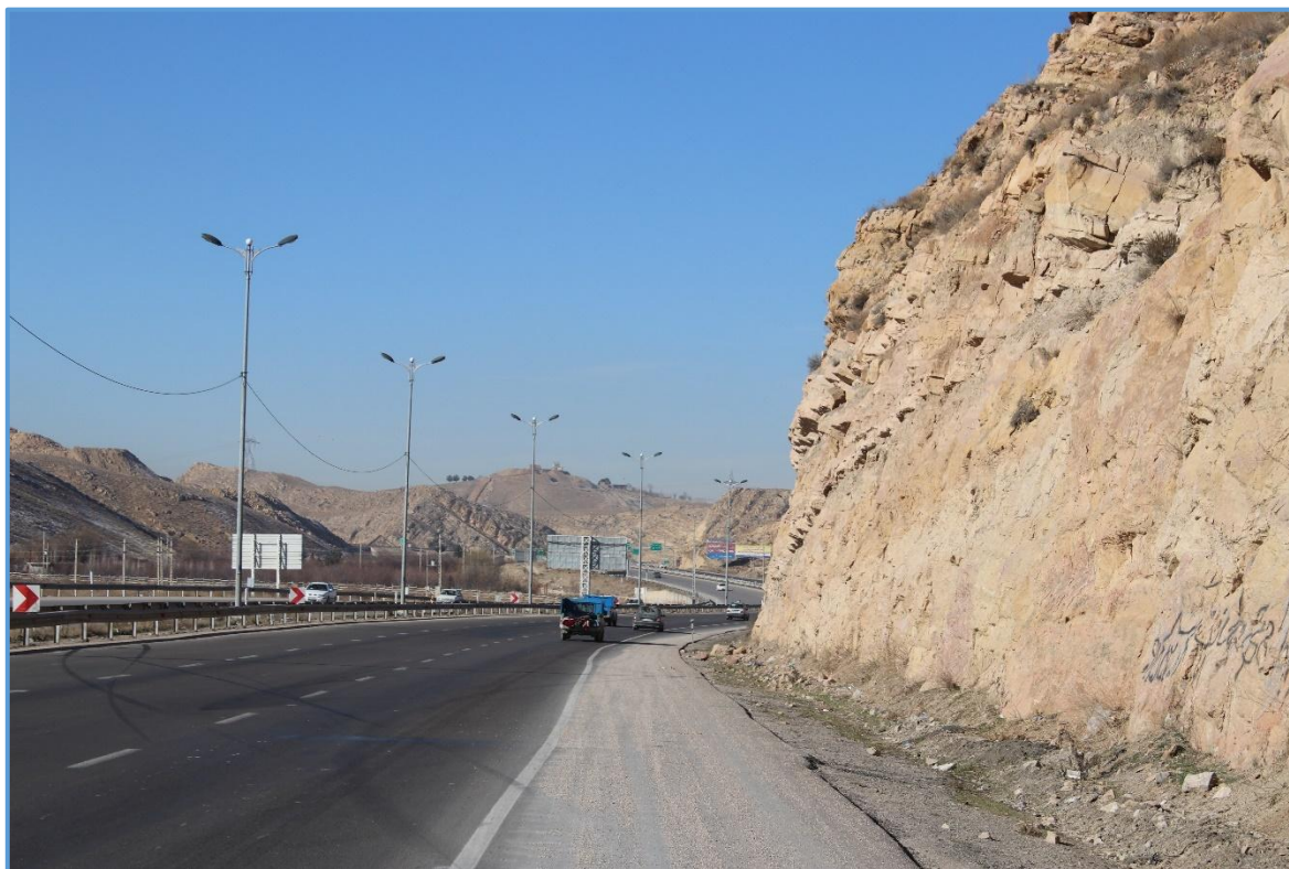
شکل ۲۰- خطر سقوط و پرتاب سنگ در اثر عدم پیش بینی حاشیه ایمن جهت مهار سقوط سنگ - کیلومتر ۵۴ محور شیروان به بجنورد (دید به باختر) ( 37^{\circ}28'38.03''N-57^{\circ}25'35.79''E )
