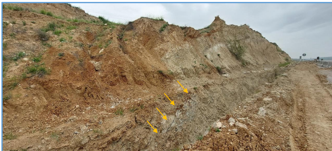
شکل ۸- ایجاد سطوح شکست برشی ناشی از ایجاد کانال زه کش در پاشنه توده رانشی و عدم رعایت مدت زمان مجاز عملیات ایجاد و بهسازی مجدد پاشنه توده جهت زهکشی زیرزمینی (دید به خاور)
