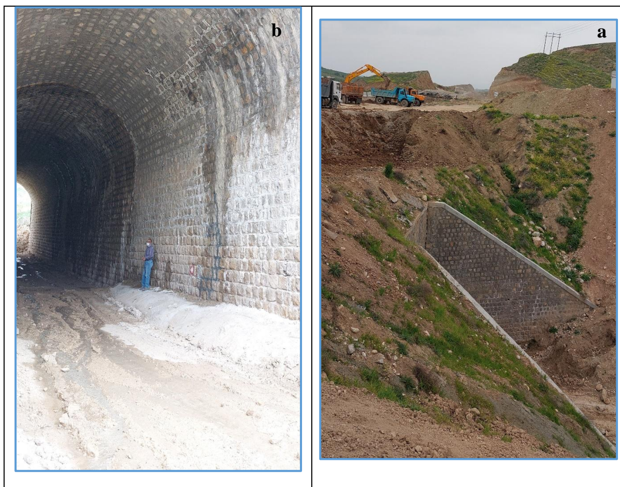
شکل ۱۳- نمایی از پل زهکش آبراهه a: ورودی پل در شمال جاده b: زه آب ناشی از عدم تعبیه زهکش مناسب در دیواره های داخلی پل از زیراساس و اساس راه
