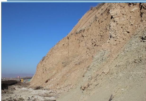
شکل ۱۶- خطر رانش در اثر عدم اجرای استاندارد تراس های پلکانی و عدم رعایت تناسب ارتفاع به پاشنه در کاهش شیب دامنه و ناپایدارسازی بیشتر دامنه - کیلومتر ۱۸ محور بجنورد- آشخانه ( دید به باختر)- (37°31'10.48"N-57° 8'57.32"E)
