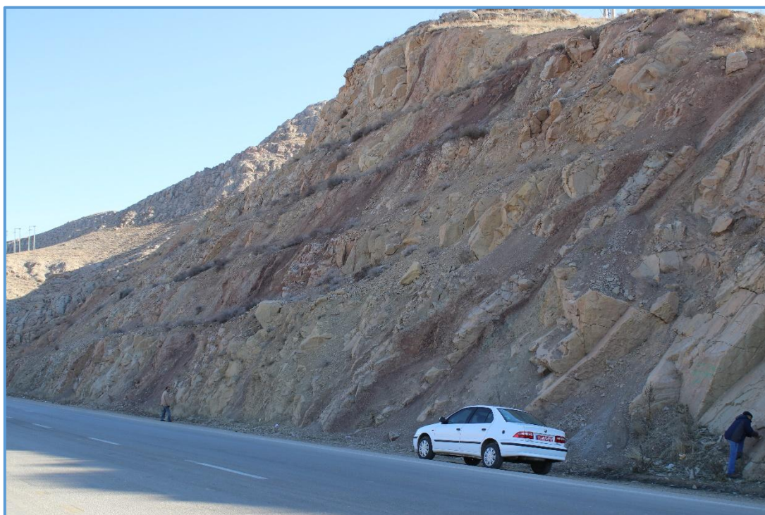
شکل ۱۸- خطر سقوط و پرتاب سنگ در اثر عدم پیش بینی و طراحی حاشیه ایمن جهت مهار سقوط سنگ - کیلومتر ۷ محور بجنورد به شیروان - روبروی پارک بابا امان (دید به شما خاور) (37°29'21.74"N-57° 26'23.05"E)
