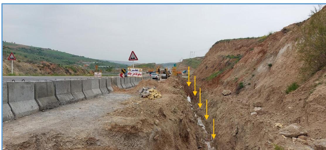
شکل ۷- نمایی از ایجاد کانال زهکش در پاشنه توده رانشی در دومین رخداده رانش در فروردین ماه سال ۱۴۰۱ جهت تعبیه لوله زهکش (دید به جنوب خاور)
