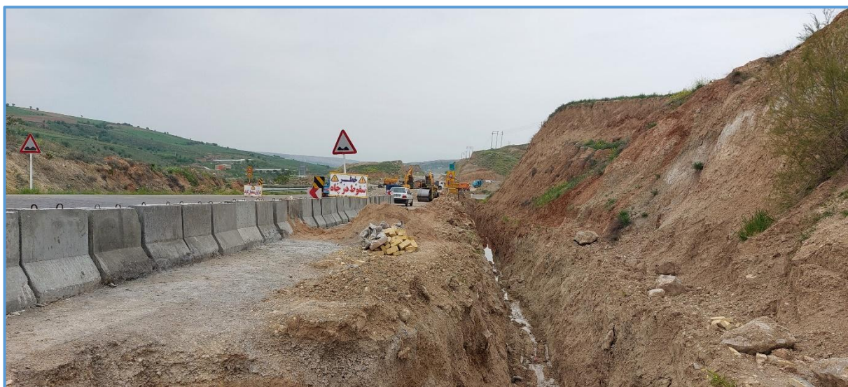
شکل ۱۱- نمای زهکش موقت در پاشنه توده رانشی در بالادست جاده بادی ۲ لیتر بر ثانیه ( دید به شمال باختر )
